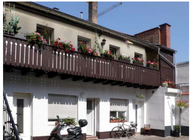
Hinterbau Rohrbacher Straße 62, nach Wärmedämmung und Verputzen der Fassade durch das OBDACH-Arbeitsteam.
