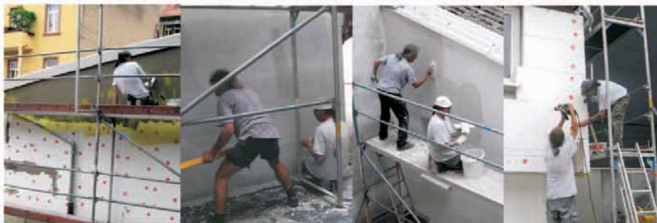
Das OBdach-Arbeitsteam beim betreuungsgerechten Umbau in der Rohrbacher Straße 62
