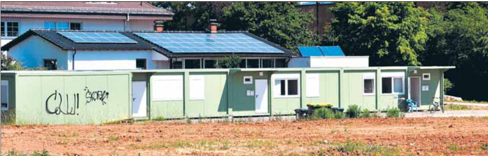
Derzeit bringt die Stadt Eppelheim Obdach- oder Wohnungslose in diesem Containerdorf am Rande der Stadt nahe der Eishalle unter. Foto: Geschwill
